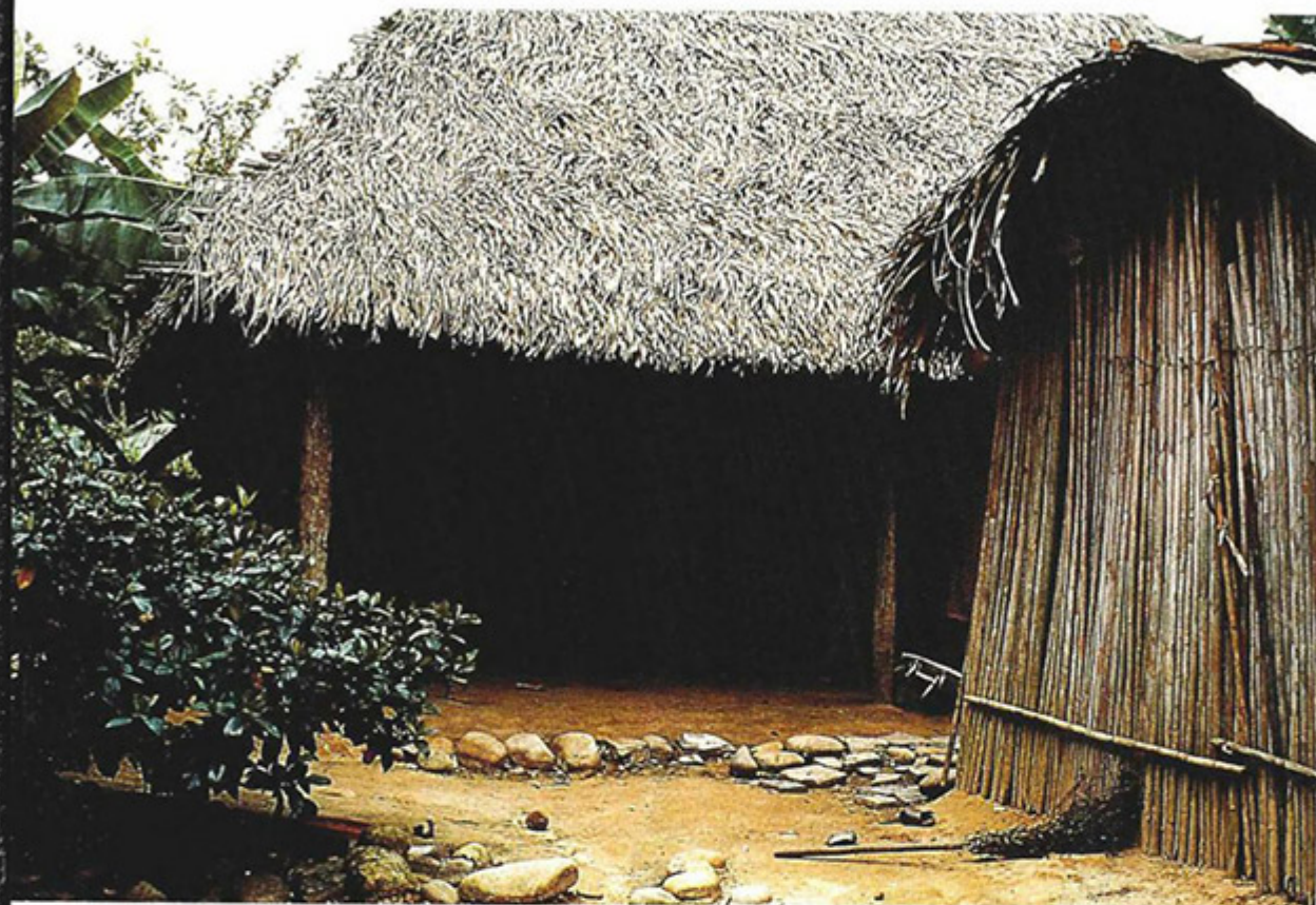
Figura 4: Vivienda típica infestada por los insectos transmisores de la enfermedad, caracterizada por tener techo de palma y paredes de bahareque. (Cortesía de A. Corredor, Instituto de Salud en el Trópico, Facultad de Medicina, Universidad Nacional, Santafé de Bogotá, Colombia).
