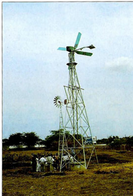
Figura 6. Aerogenerador mixto (bombeo de agua y generación de electricidad) de 2 kw, instalado en el campo de pruebas de La Guajira, Universidad Nacional - SENA.
