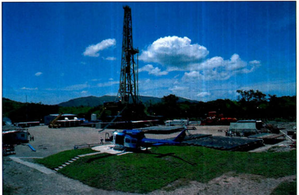
Figura. Cusiana, una realidad de 2700 millones de barriles de petróleo.
